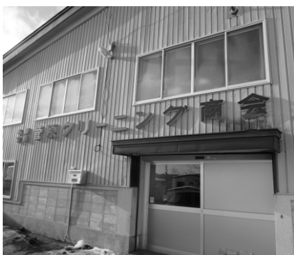
現在の本社と工場
